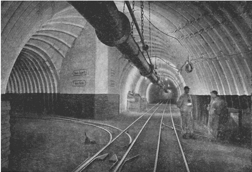
Der ausgebaut Franzschacht 1953: Das Vierwegekreuz auf der 610-m-Sohle
